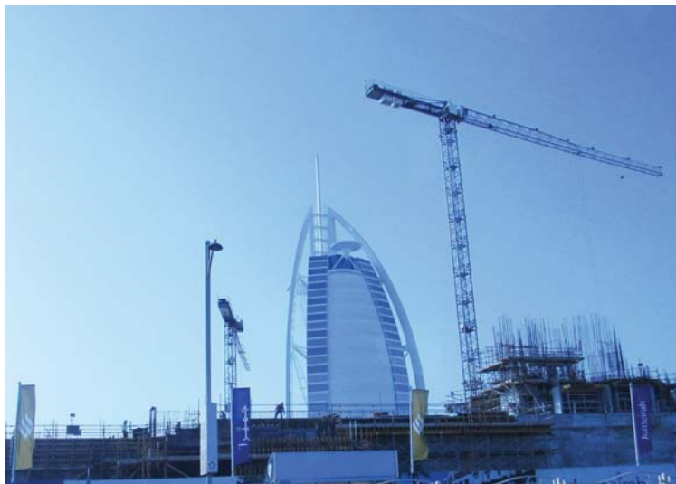
جانب من أعمال البناء
