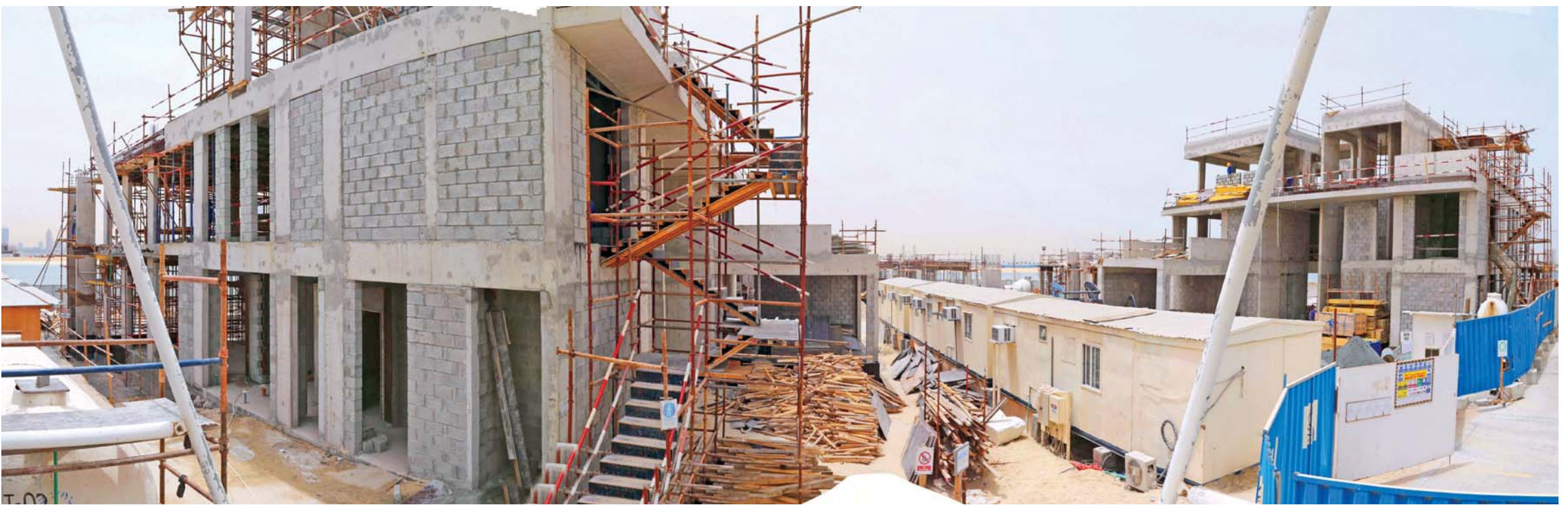
أعمال البناء في المشروع
