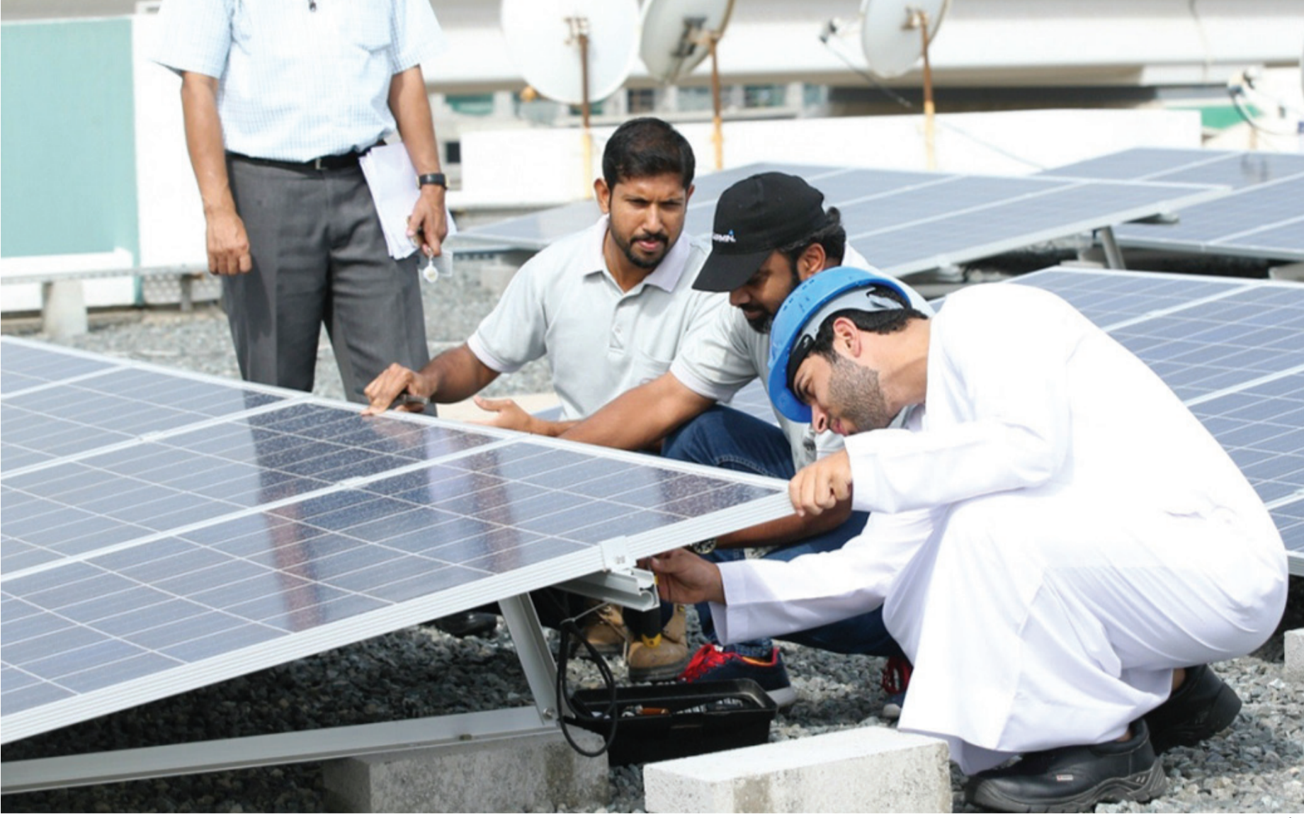
■ أثناء تركيب الألواح الشمسية لإحدى المنشآت
