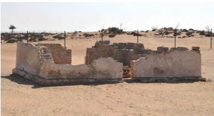
■ أحد المباني المكتشفة في الموقع بعد ترميمها | من المصدر
