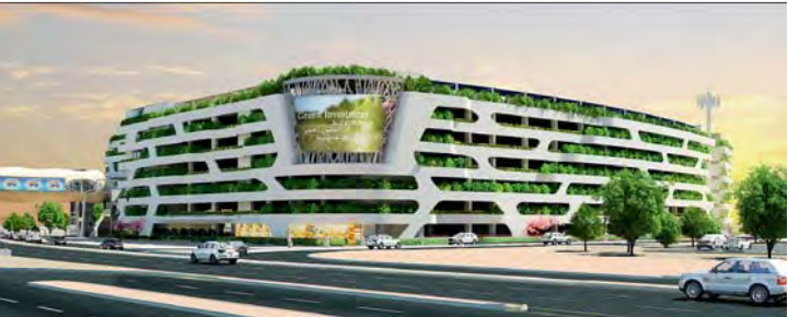
■ مبنى مواقف السيارات متعدد الطوابق | البيان
