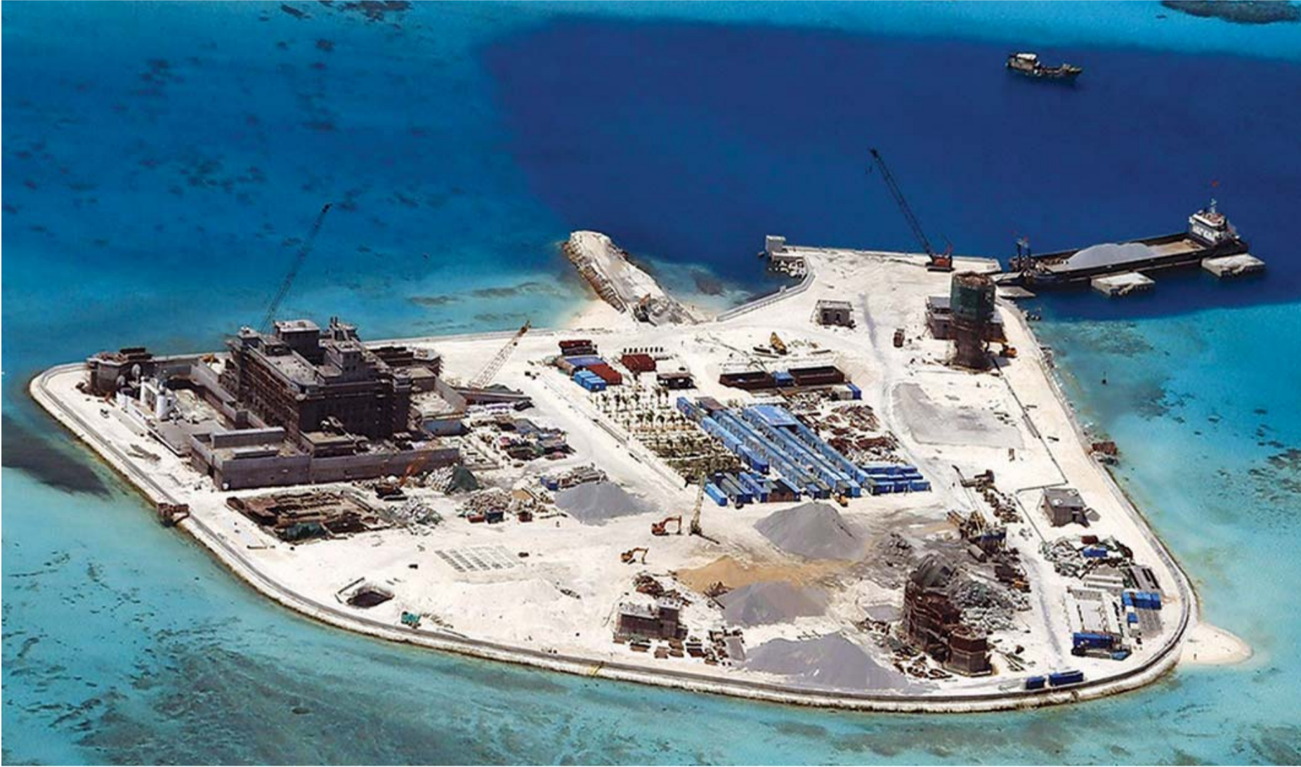
■ الجزر الصينية تثير توتراً محتدماً في بحر الصين الجنوبي | أرفشيفية
