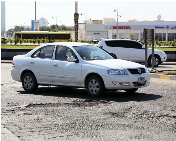
■ تشقق الأسفلت يسهم في عمل مطبات صناعية وشكل غير حضاري في الطرقات
