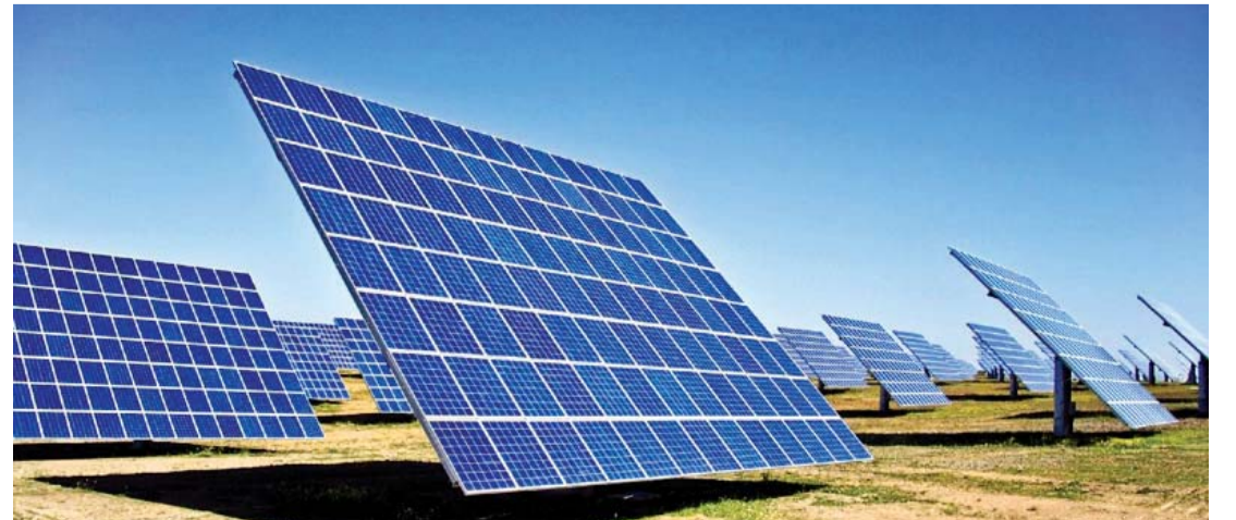
ألواح توليد الكهرباء من الطاقة الشمسية
