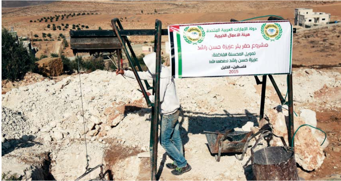
■ جانب من أعمال حفر الآبار | وام
