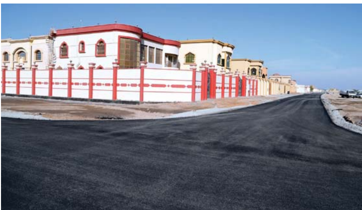
■ انتهاء أعمال رصف الطرق في شعبية حليبة | من المصدر
