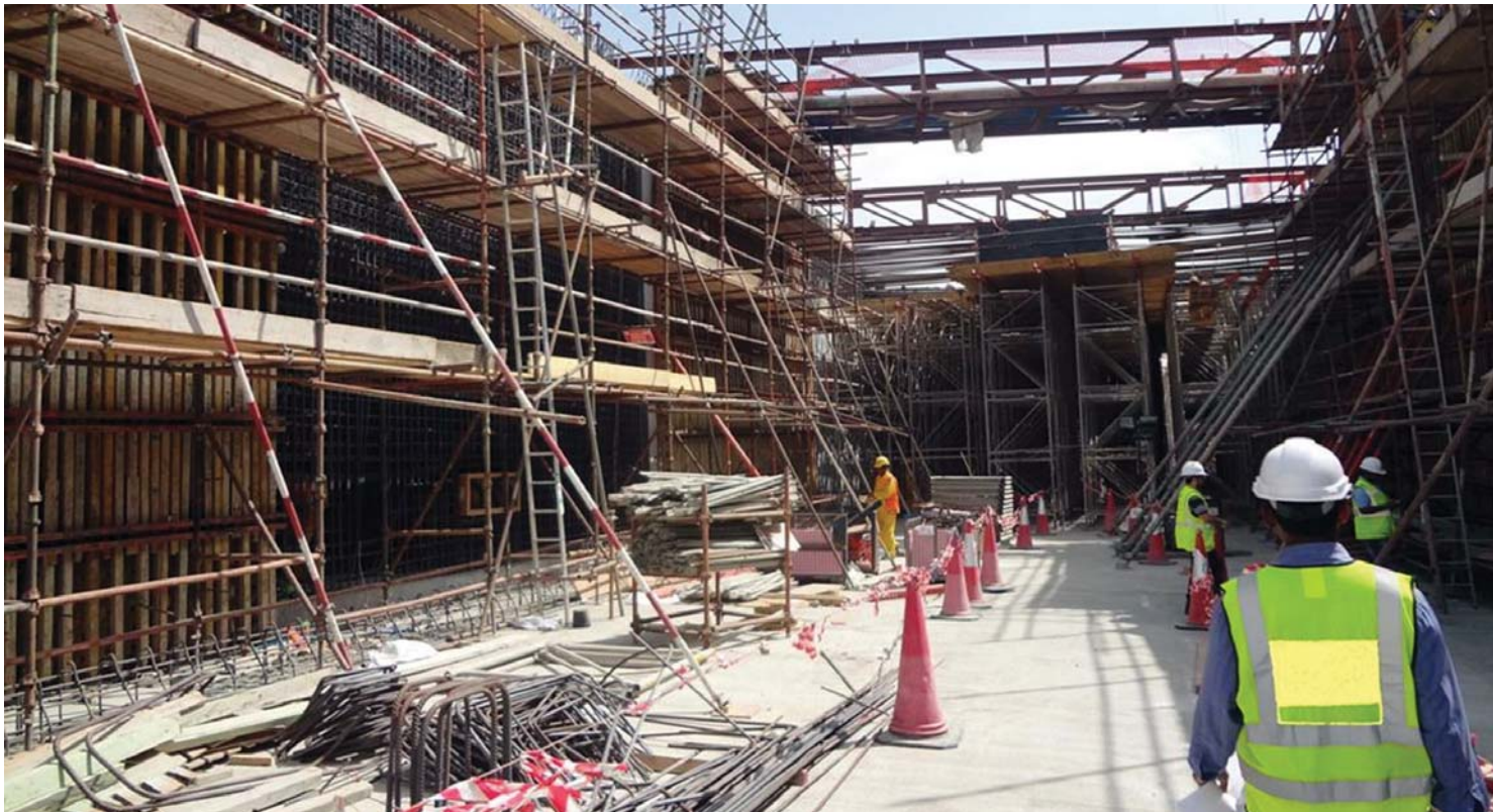
■ عمال في أحد مواقع البناء والتشييد | أرشفية
