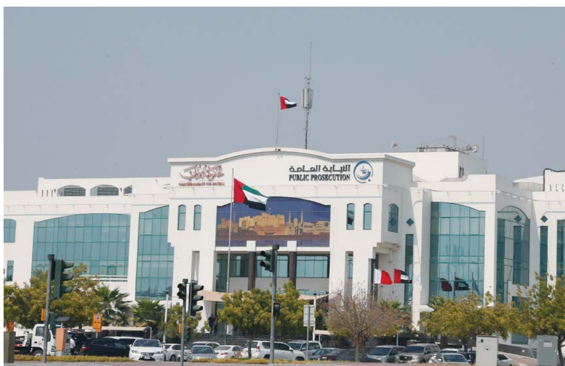
■ العلم مرفرفاً فوق مبنى النيابة العامة في دبي | البيان
