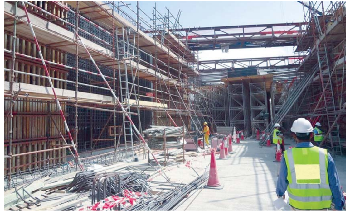
■ بلدية أبوظبي تحرص على تأمين بيئة عمل متكاملة في مواقع البناء | من المصدر
