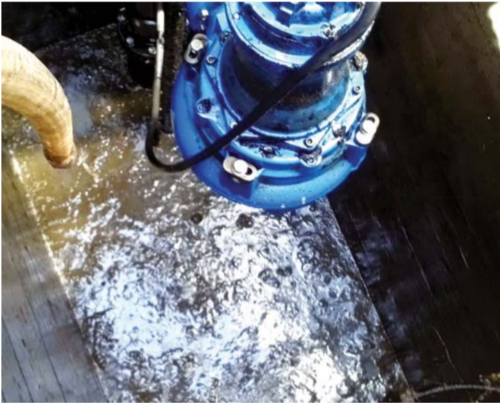
عمل دووب لاصلاح أنابيب المياه التالفة
