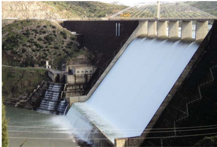
سد بني هارون في ولاية ميلة شرق الجزائر تبلغ طاقة استيعابه مليار متر مكعب
