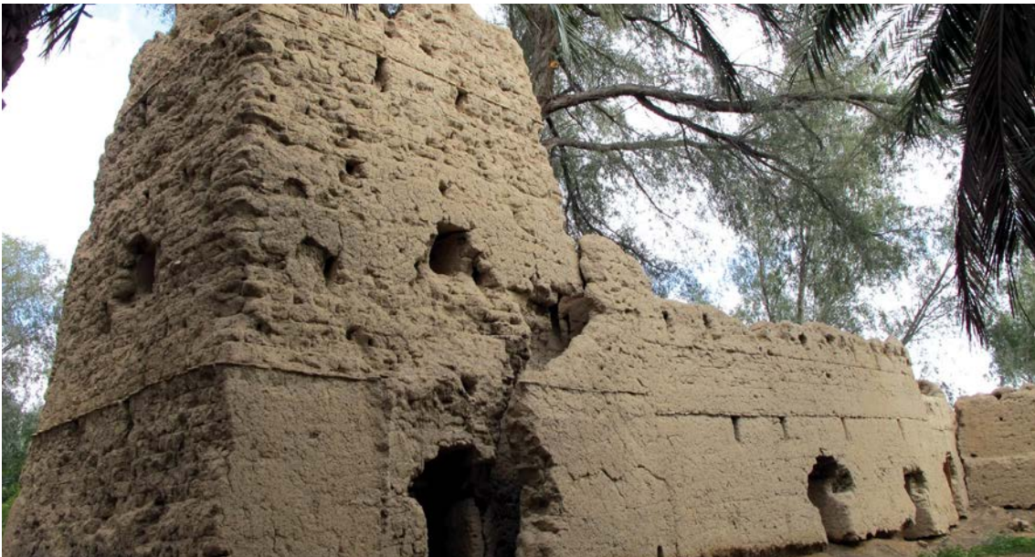
ترميم البيوت القديمة
