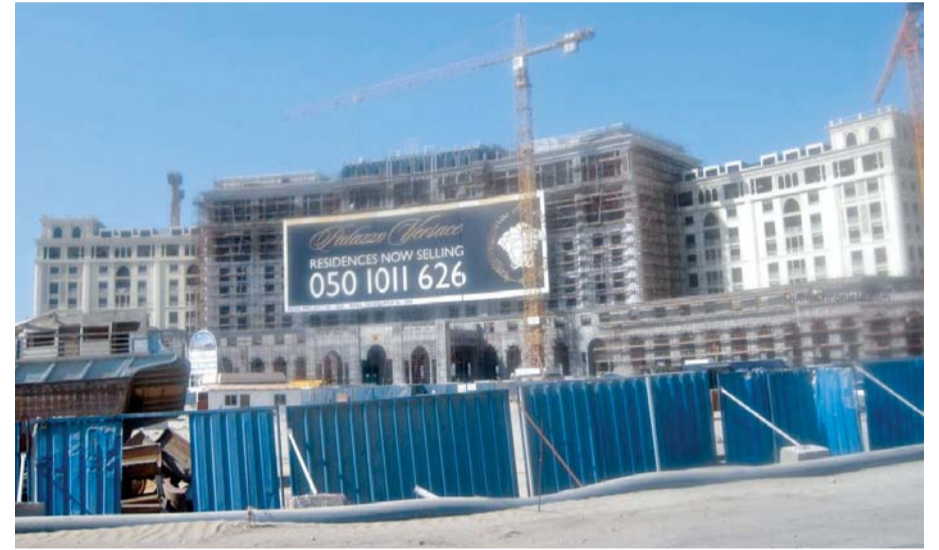
■ جانب من أعمال البناء في 2012
