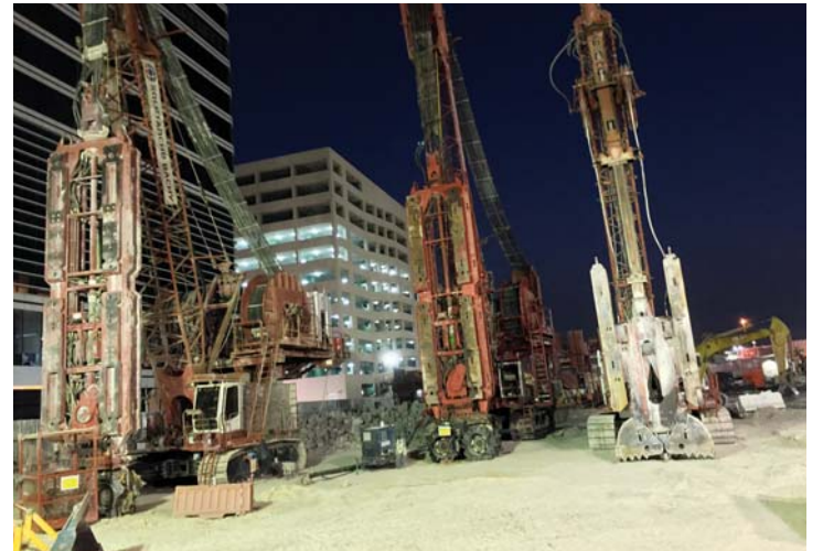
■ آليات البناء في الموقع
