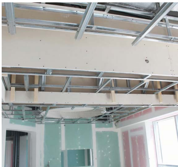
الأعمال الإنشائية في إحدى طبقات المشروع
