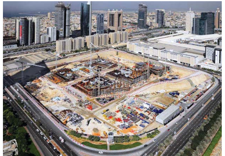
تطور أعمال البناء
