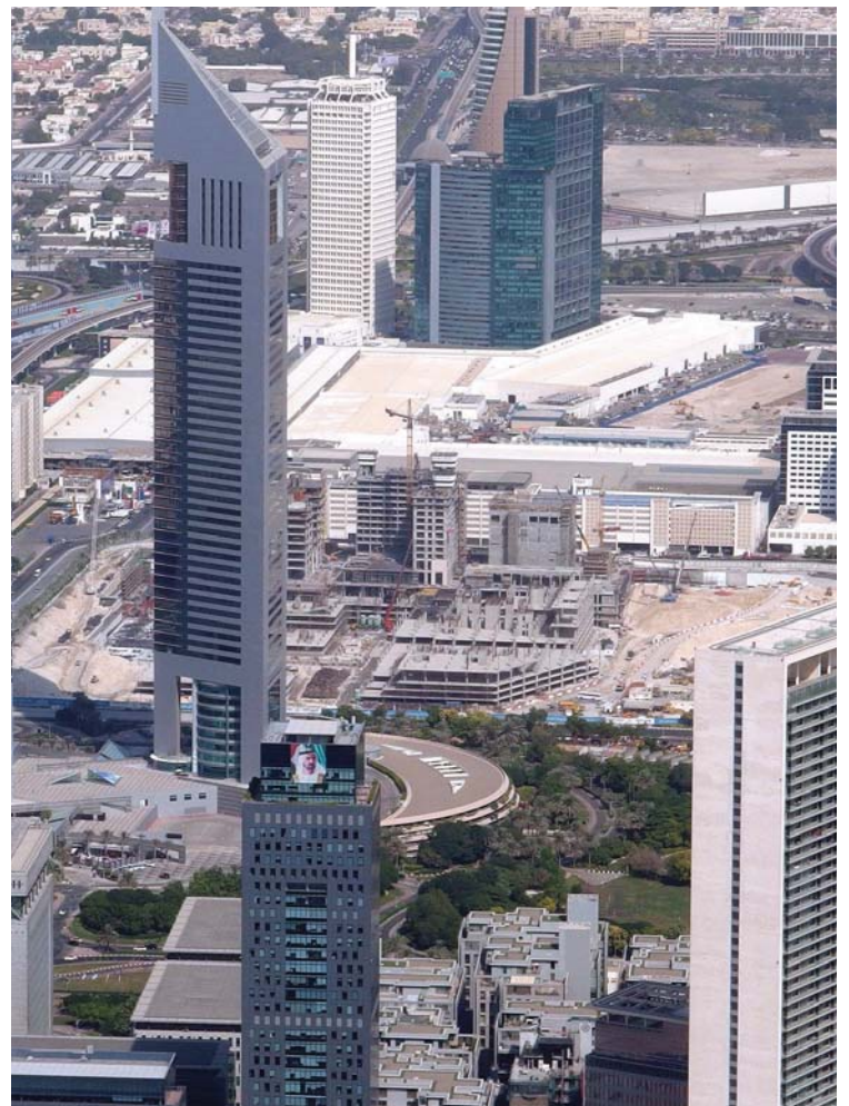
أعمال البناء في المشروع
