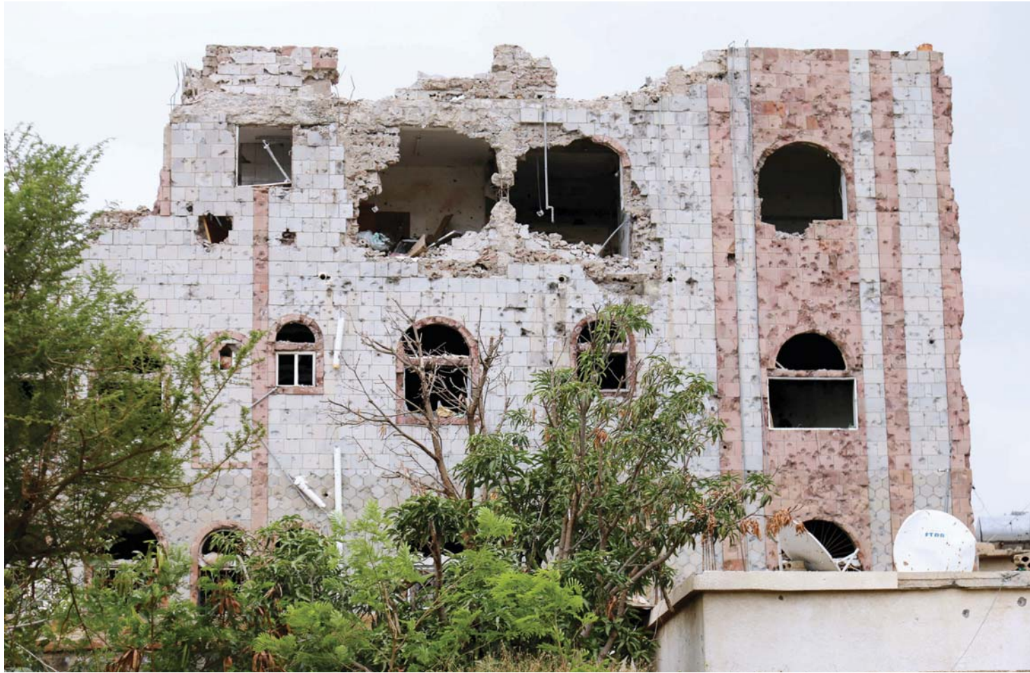
■ أضرار كبيرة تظهر على مبنى سكني في تعز جراء قصف الانقلابيين | تصوير: أحمد الباشا
