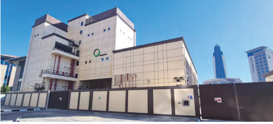
الهيئة دشنت 13 محطة نقل كهرباء رئيسية جديدة بجهد 132 كيلوفولت | من المصدر
