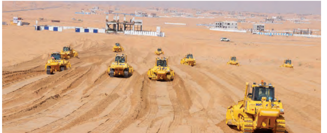
خلال أعمال التسوية في أحد مشاريع بلدية الشارقة | من المصدر
