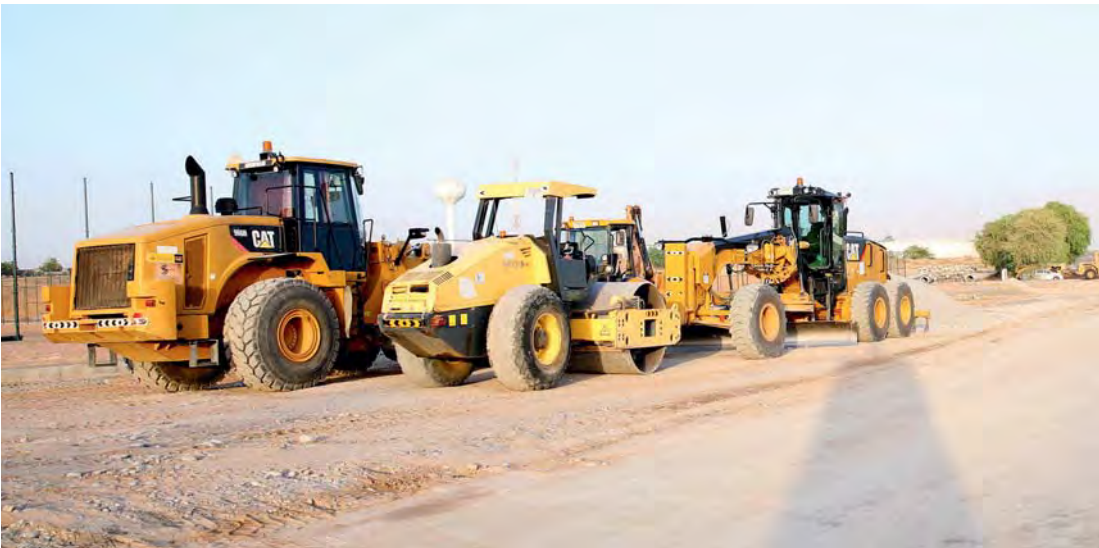
■ انطلاق أعمال إنشاء ملاعب جديدة في نادي الإمارات | البيان
